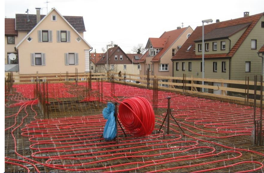
Eisbärhaus Bauteil A + B
